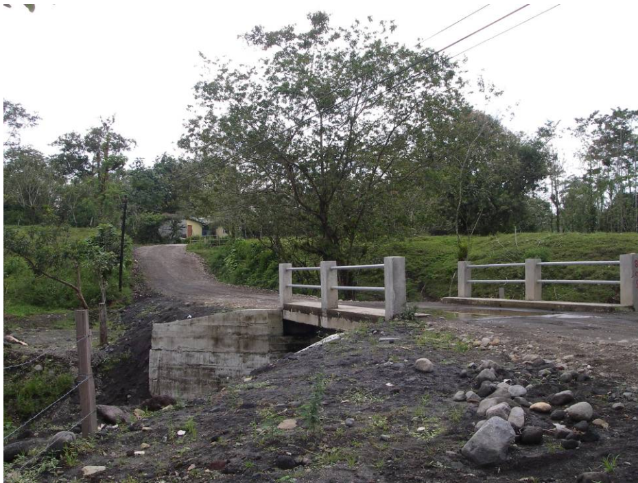
Figura 9: Puente sobre el río Burío viendo hacia el sur. El volcán se encuentra hacia el lado derecho de la fotografía.
