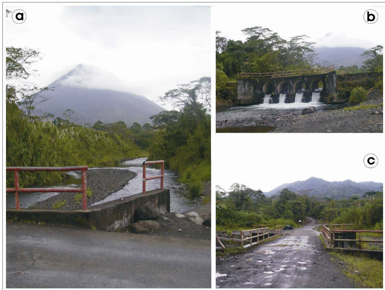
Figura 8: a) Puente Aguacaliente viendo hacia el Arenal, al este, desde la calle. b) Puente Aguacaliente viendo hacia el Arenal, desde aguas abajo. c) Puente Aguacaliente viendo hacia El Castillo, hacia el sur.
