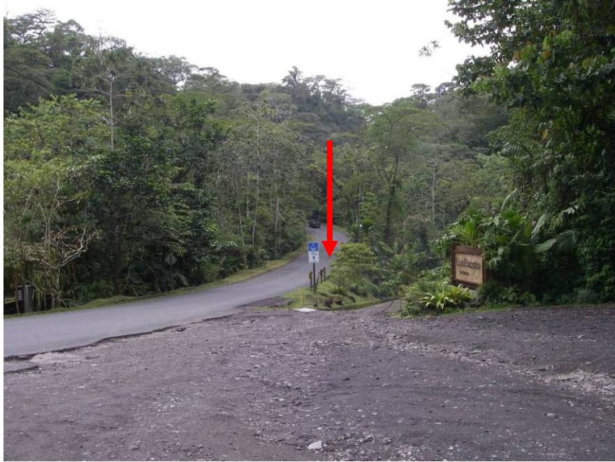
Figura 6: Paso por el río Tabacón viendo hacia el oeste. El paso del agua es a través de tubos de alcantarilla, algunos metros debajo de la señal de tránsito, en la flecha roja.
