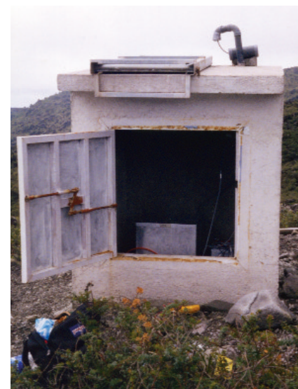
Caseta de vigilancia geofísica construida en el flanco oeste del volcán.
