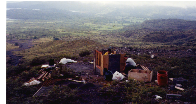
Construcción de la caseta.
